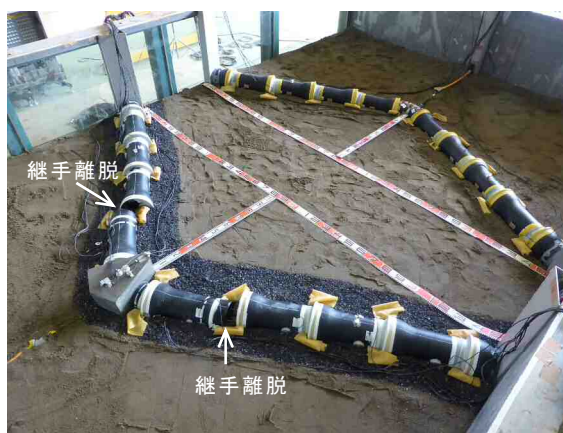
Fig.3 振動実験で離脱した屈曲部近傍の継手
