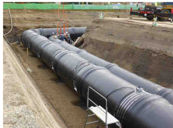
Fig.6 鎖構造継手管路による復旧
